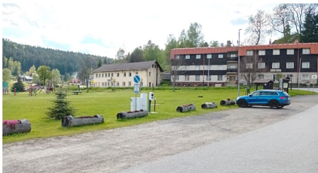
Fotografie řešeného území od východu. V popředí je silnice od Zátone s plochou pro parkování, v pozadí zástavba za hlavní silnicí.
