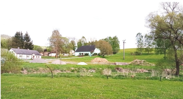
Pohled směrem jihovýchodním na koryto Kubohuťského potoka, kde je počítáno s úpravou nivy a vybudováním parkoviště. V pozadí tradiční chalupy Horní Vltavice.
