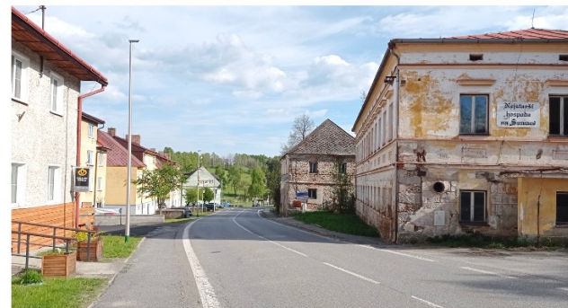
Hlavní silnice z Vimperka do Bavorska prochází jádrem Horní Vltavice. Vpravo historické objekty dvorce bývalé hospody na Zlaté stezce. Řešené území v pozadí v ose ulice.
